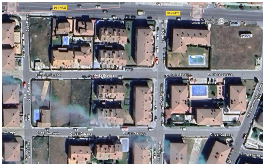
Segundo tramo de conexión con la carretera SG-V-6123 con manzanas que cuentan plazas de aparcamiento que se añaden a los aparcamientos privados en su interior..
