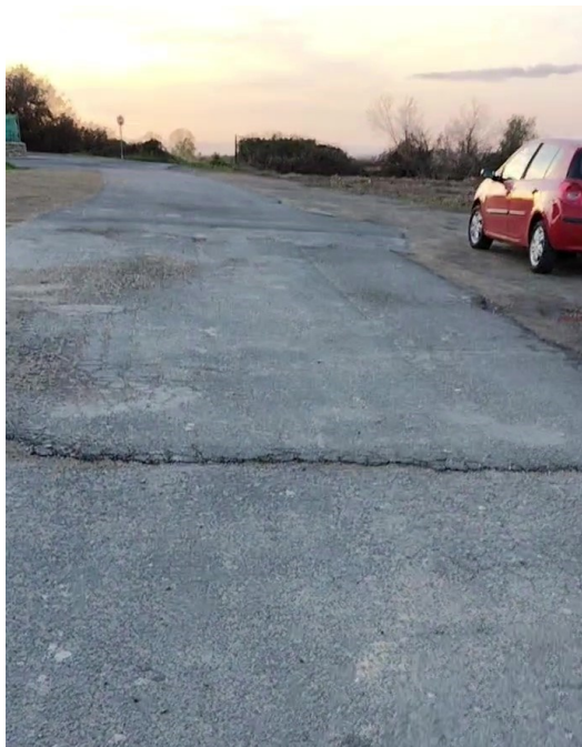
Vista de la Calle Linares, hacia el oeste
